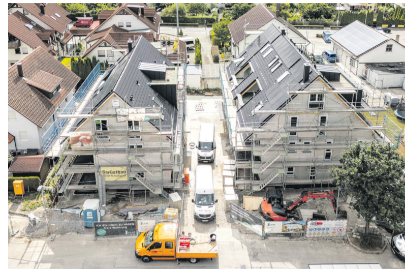
Ein Blick auf die Baustelle in der Schillerstraße in Herrenberg.
